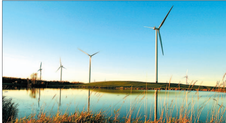
Imagen del parque eólico de Maple Ridge de Iberdrola Renovables en Nueva York.
